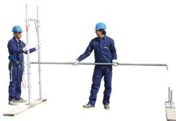
4 • založení podélné tyče
