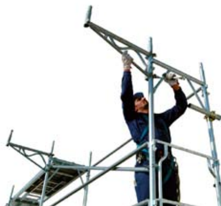
59 • montáž konzoly se vzperou
