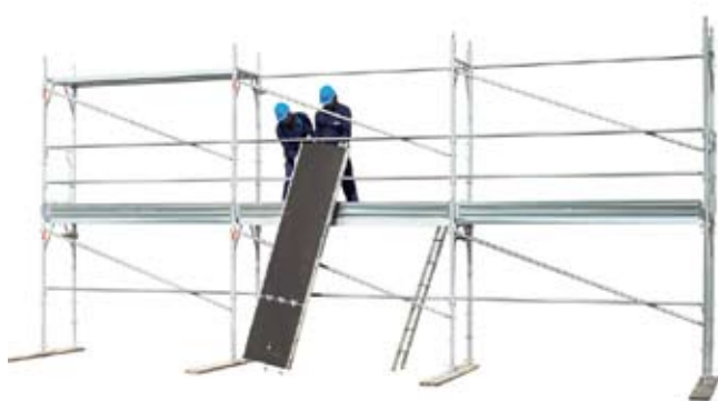
45 • montáž desek s prulezem na podlaží 2
