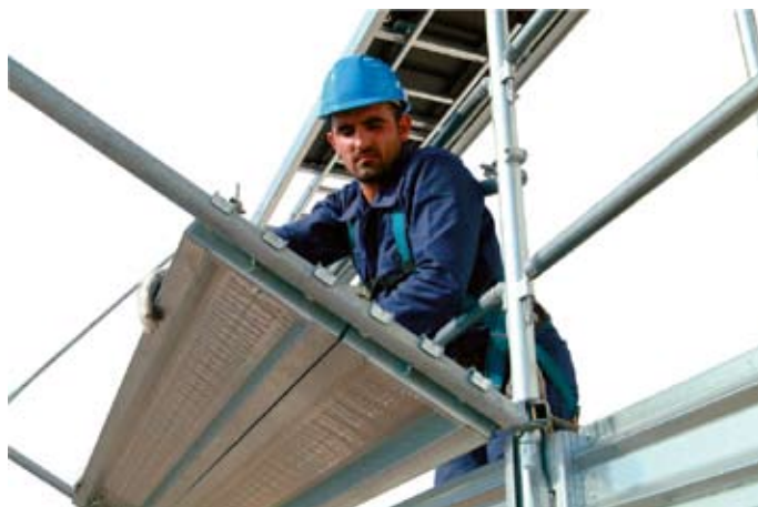
58 • detail montáže desek "protiskálních" zábran
