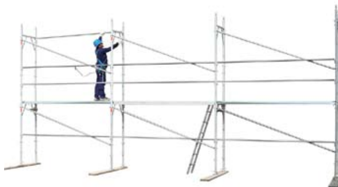
35 • montáž zadní příčky na podlaží 1
