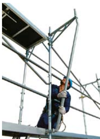
60 • montáž vzpery konzoly
