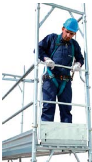
41 • montáž celného parapetu na podlaží 1
