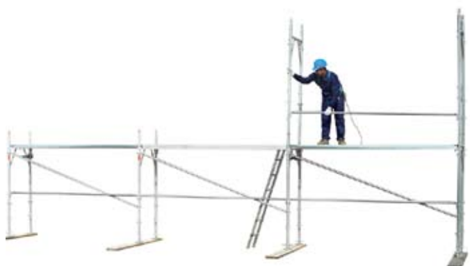
31 • montáž podélné tyce na podlaží 1
