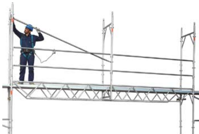
70 • montáž předních příček nad "prujezdovými" nosníky
