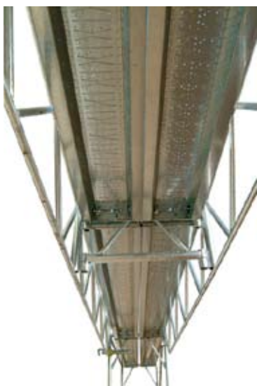
68 • montáž bednění pod "prujezdovými" nosníky
