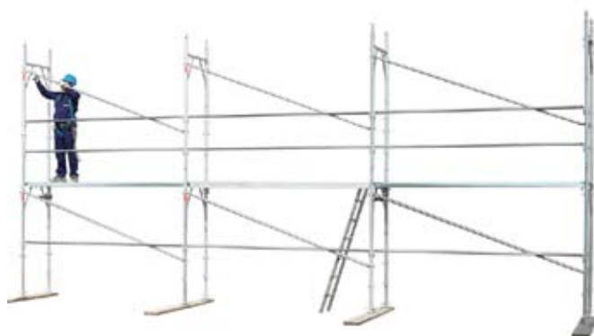
34 • montáž dalších modulu na podlaží 1
