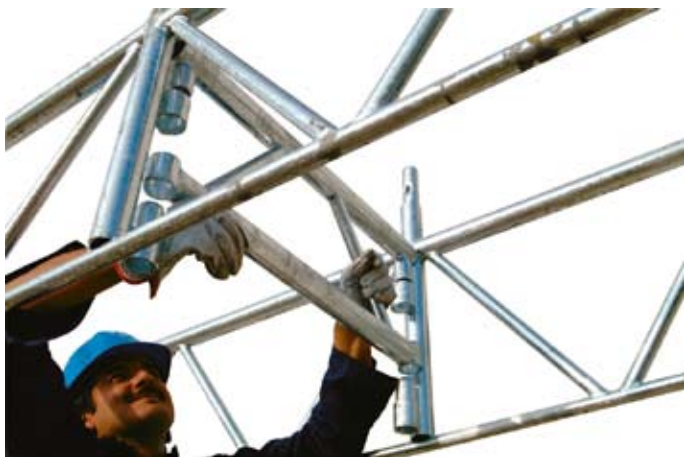
67 • montáž spojovacího trámu "prujezdových" nosníku
