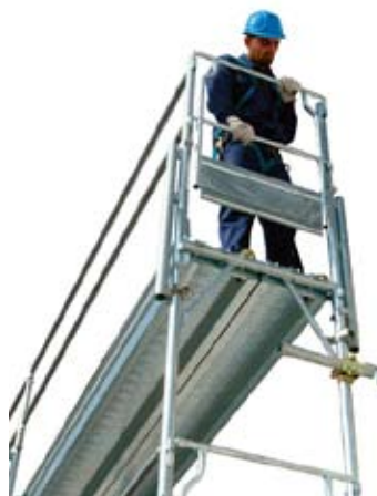
52 • montáž celného parapetu podlaží 2
