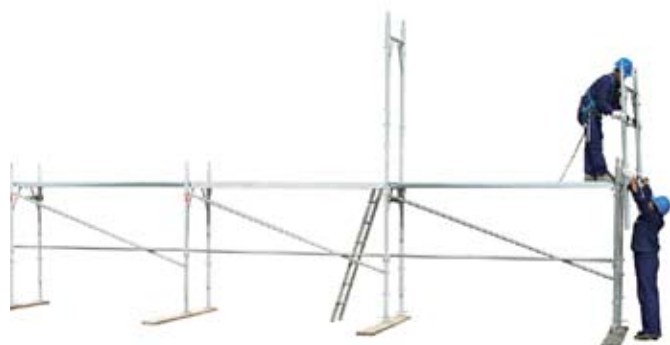
28 • montáž rámu podlaží 1
