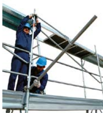
54 • detail "protiskálních" zábran
