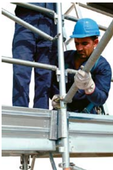
55 • detail "protiskálních" zábran
