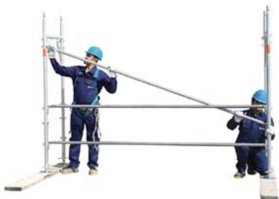
7 • montáž příčné vzpery
