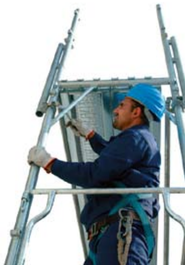
49 • utažení spoje vrcholového stojanu na podlaží 2
