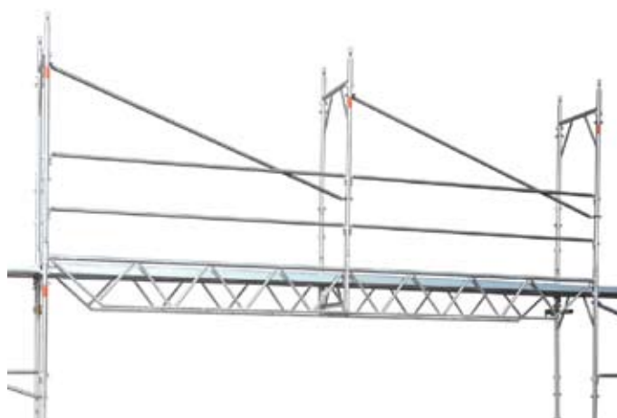
71 • ukončená montáž nad "prujezdovými" nosníky
