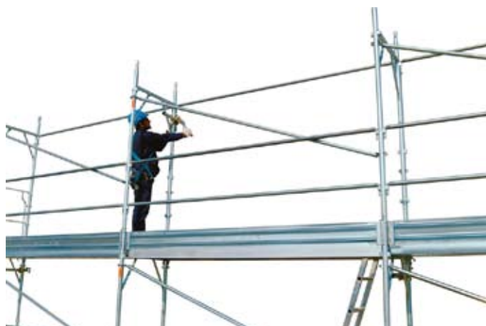
42 • montáž ukotvení na podlaží 1 dle požadavku
