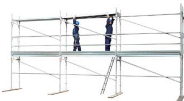
46 • montáž desek s prulezem na podlaží 2
