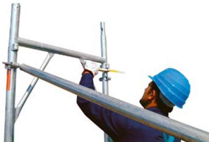
9 • kontrola vzdálenosti od fasády
