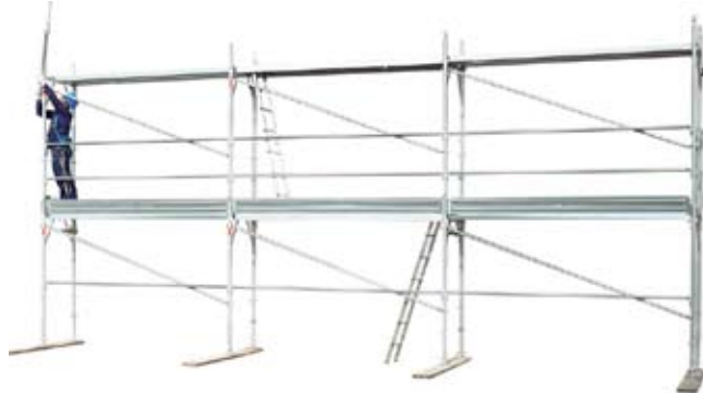
48 • montáž vrcholového stojanu na podlaží 2
