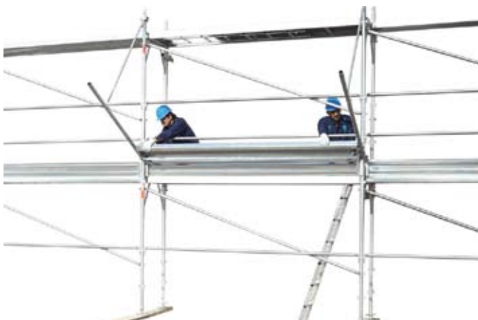
56 • montáž desek "protiskálních" zábran
