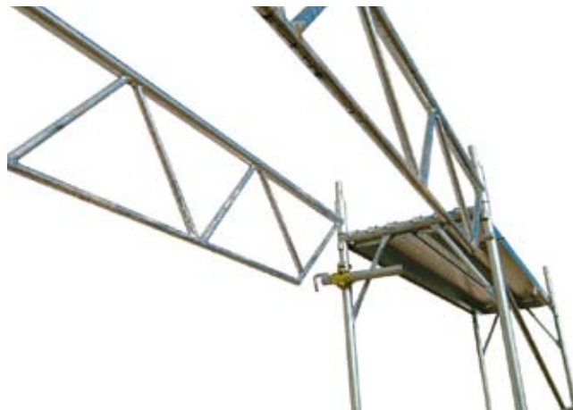
66 • montáž "prujezdového" nosníku
