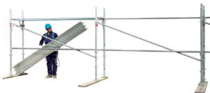
17 • montáž kovových desek
