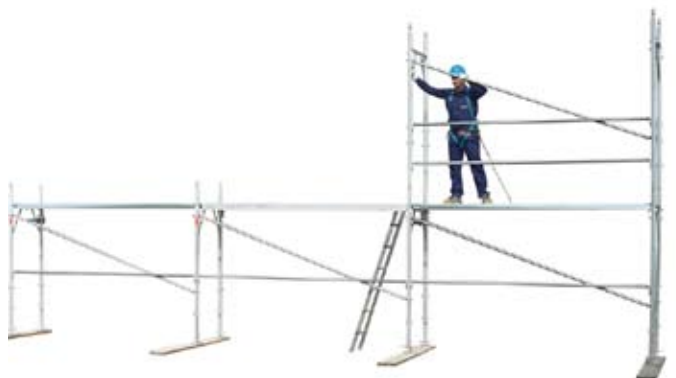
33 • montáž přední příčky na podlaží 1
