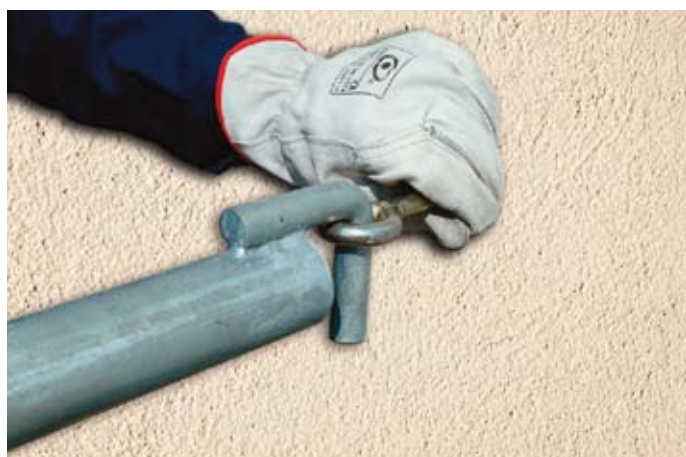
15 • založení ukotvení
