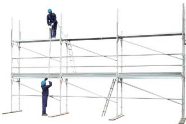
51 • montáž podélných tyčí a parapet podlaží 2
