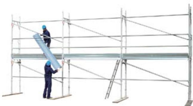
43 • montáž desek na podlaží 2
