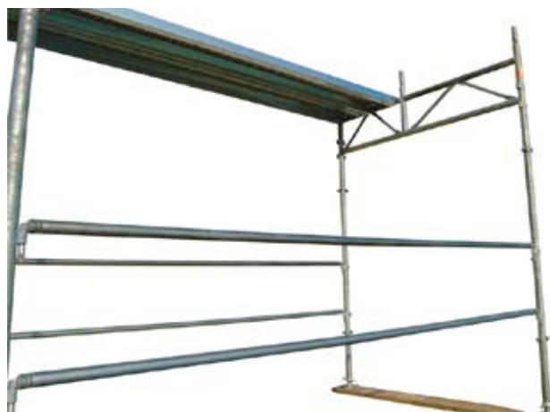
65 • montáž desek na rám přechodu pro chodce
