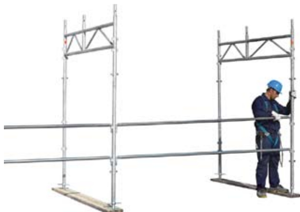
64 • montáž propojení rámu přechodu pro chodce
