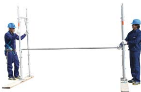
5 • montáž druhého rámu s parapetem
