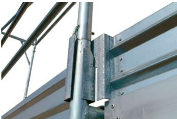
38 • detail zábran na podlaží 1
