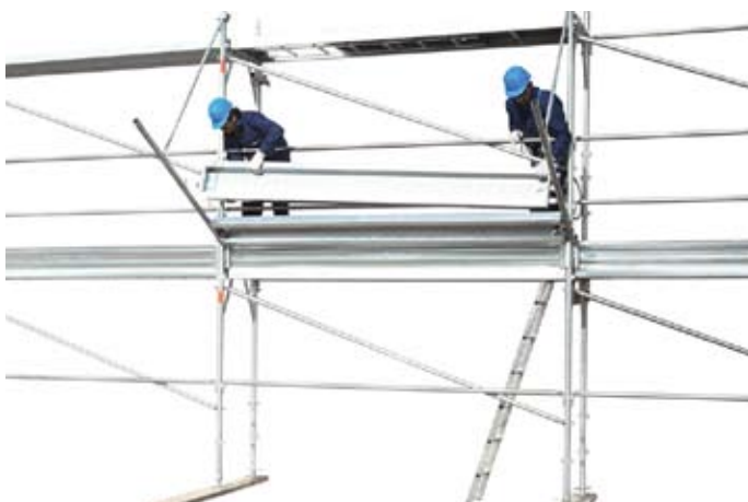
57 • montáž desek "protiskálních" zábran
