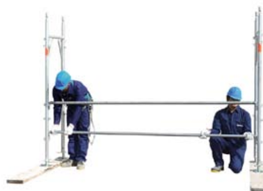
6 • montáž druhé podélné tyče
