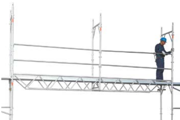
69 • montáž rámu a podélných tyčí nad "prujezdovými" nosníky
