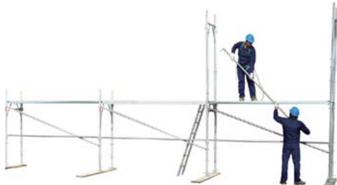
30 • montáž podélné tyče podlaží 1
