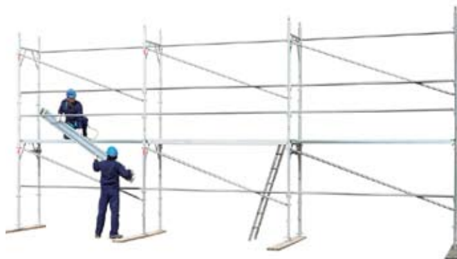
36 • montáž zábran na podlaží 1
