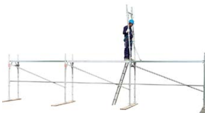
27 • montáž rámu podlaží 1
