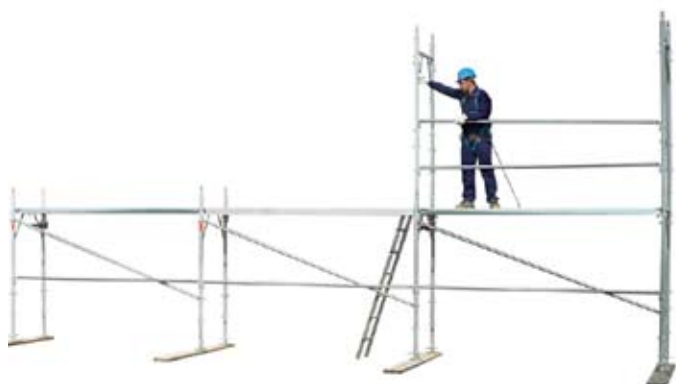
32 • montáž parapetu na podlaží 1
