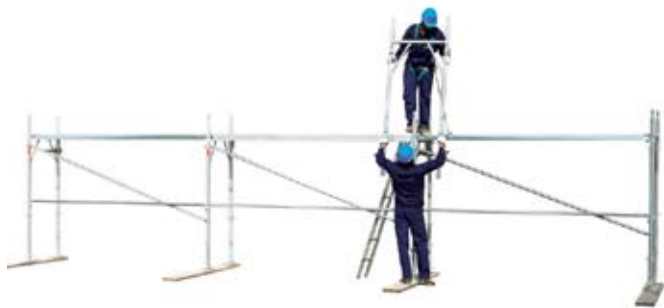
26 • začátek montáže rámu podlaží 1
