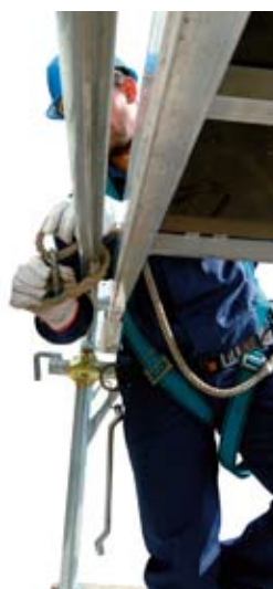
24 • připojení přídržného lana před výstupem na podlaží
